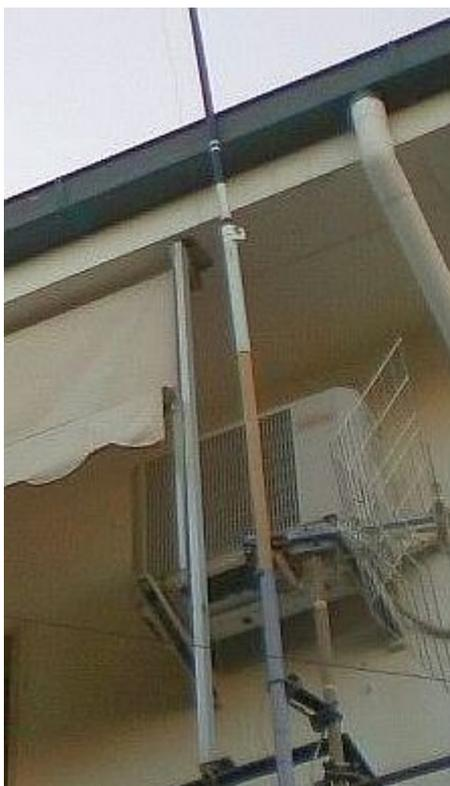
dettaglio della bobina di carico: 21 spire su diametro 30 mm.
